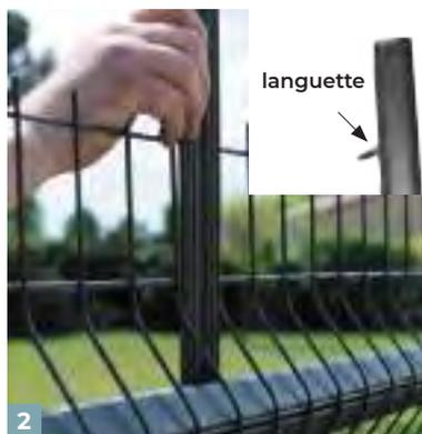
2 Glissez une latte (48 mm) **languette opposée au pli**, dans une maille au centre du panneau pour maintenir le renfort. Glissez-la jusqu'aux plis suivants. Répétez l'opération pour chacun des plis.
