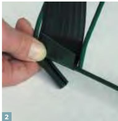
Pliez une lamelle en bas du panneau et verrouillez avec un clip, côté plié à l'intérieur du site.
