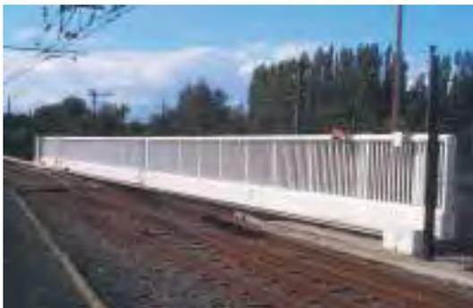
Deux portails autoportants motorisés, montés en vis-à-vis. Longueur : 34 m.
